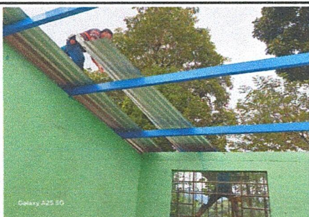
Foto 3: COLOCACIÓN DE LAMINAS
